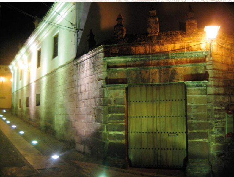
Edificio de las Tercias Catedralicias con iluminación nocturna. Foto: J. Ortiz
