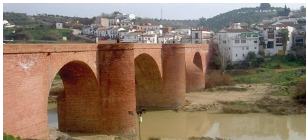
Puente Mayor de Montoro. Foto: R. Garcia
